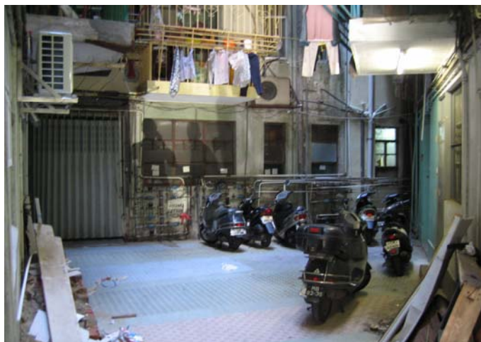
X 運大廈天井（公眾出入口通道）
